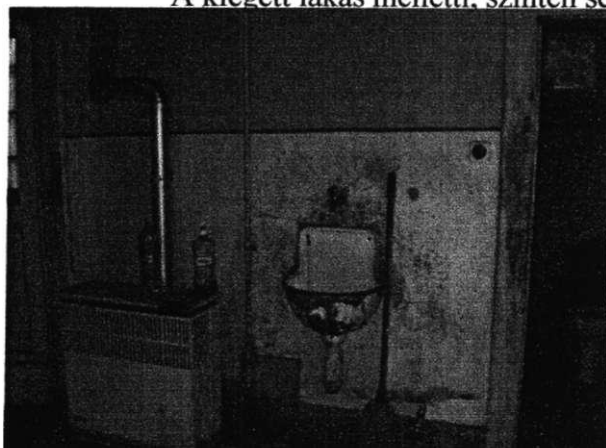
A szomszédos lakástűz oltásakor a víz is pusztított ebben a lakásban, a parketta is tönkrement
